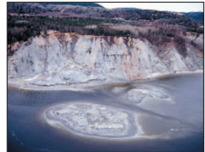
Glissement de terrain
